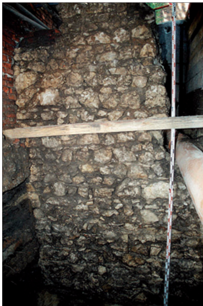
Lico ściany parteru kamienicy z 2. połowy XIV w. z widoczną partią fundamentową; odcinek muru odkryty w Ogrodzie Profesorskim przy zachodnim skrzydle Collegium Minus; w latach 1428–1475 siedziba Bursy Divitum
