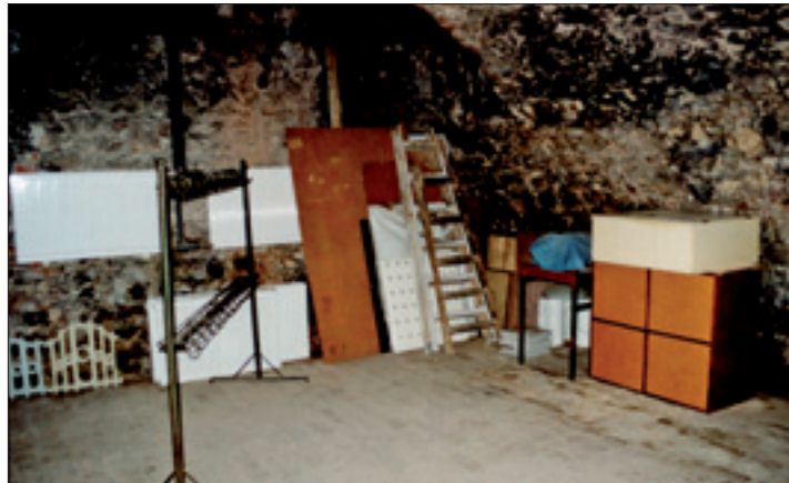
Dolny poziom piwnic Collegium Minus przed rewitalizacją z przeznaczeniem na salę odczytową
