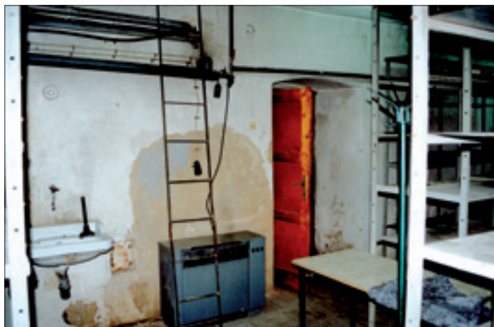
Górny poziom piwnic Collegium Minus przed rewitalizacją z przeznaczeniem na Pracownię Źródłoznawczą
