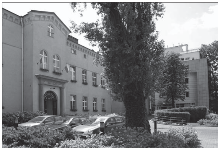
Budynek II Katedry Chorób Wewnętrznych CM UJ
