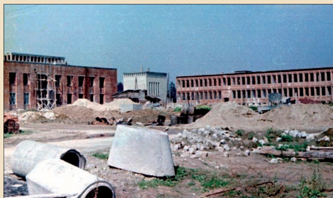
Powstają już budynki Instytutu – po lewej budynek cyklotronu U120, po prawej centralny budynek, a między nimi budynek kotłowni c.o.
