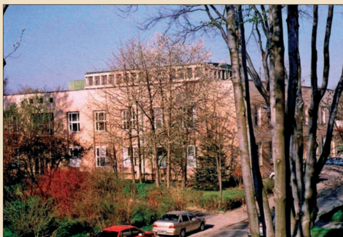
Budynek cyklotronu U120
