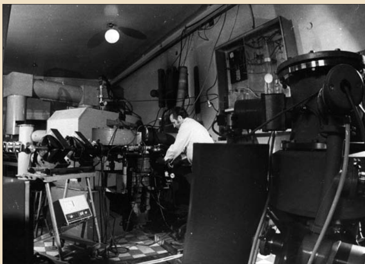
Cyklotron C-48 zbudowany własnymi siłami Instytutu Fizyki Uniwersytetu Jagiellońskiego
