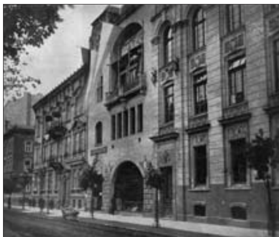
Gmach Towarzystwa Technicznego w Krakowie przy ul. Straszewskiego, otwarty 1 grudnia 1906 r.
