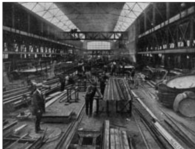
Hala główna warsztatowa na Grzegórkach Zakładu Budowy Mostów i Konstrukcji Żelaznej
