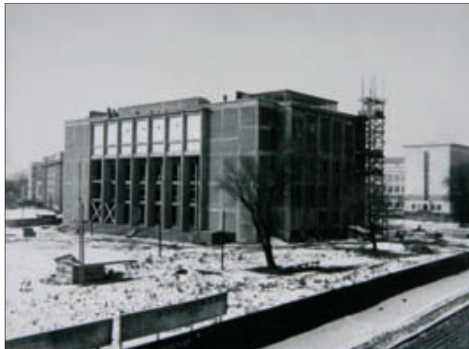
Muzeum Narodowe, plac budowy; 1934 r.
