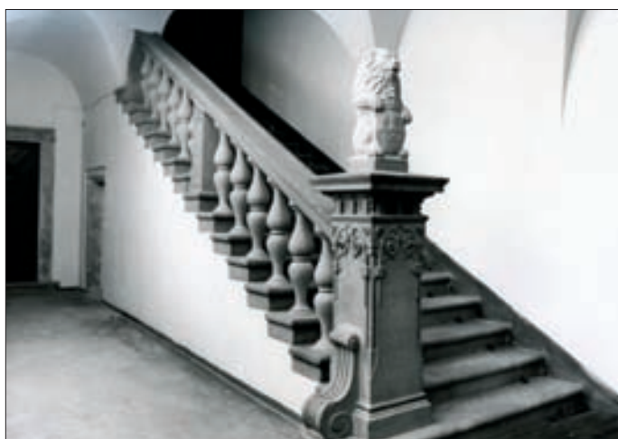
Schody w sieni parteru, stan po konserwacji
